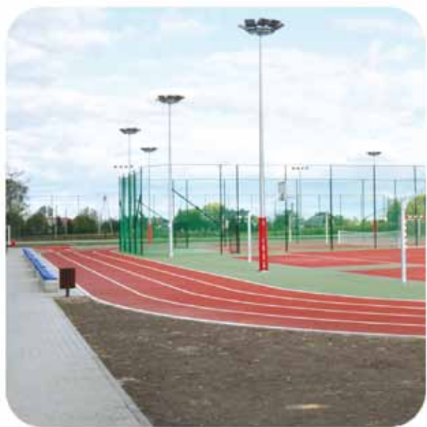
Budowa kompleksu boisk we wsi Bieniewice (gmina Błonie) Przyznana kwota pomocy 300 000,00 zł
