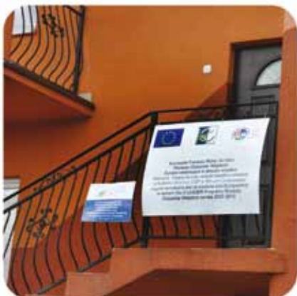
Remont świetlicy wiejskiej w budynku strażnicy OSP w Gnatowicach Starych (gmina Kampinos) Dofinansowanie 19 954,36 zł
